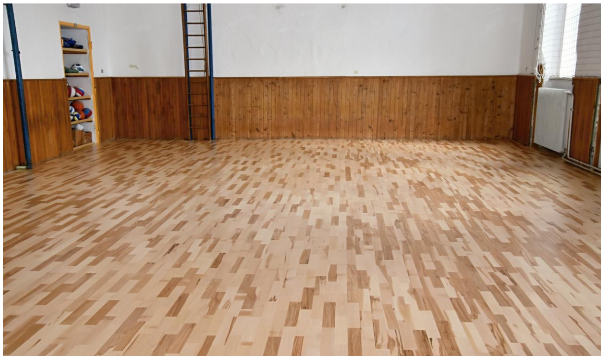
Nová podlaha v tělocvičně v Rebcově ulici zrekonstruovaná během uzavření školy
