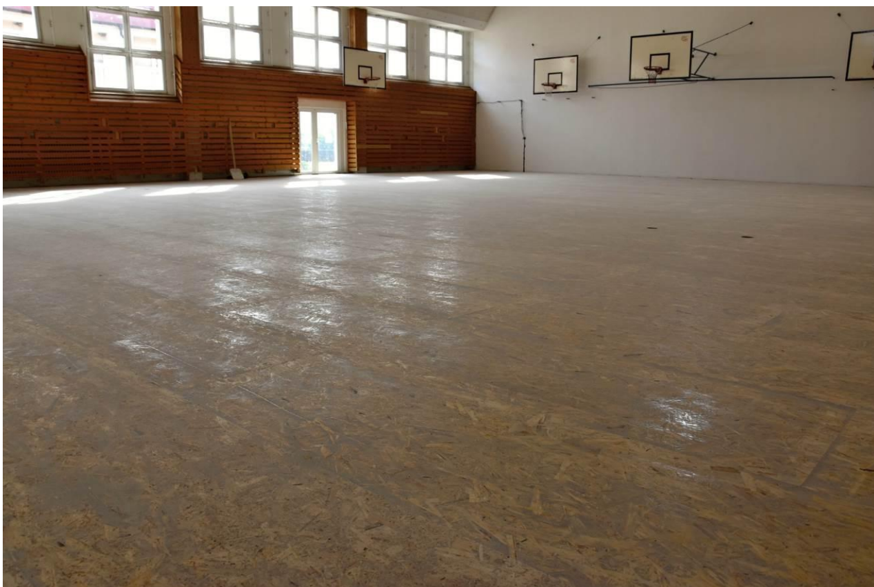
Podlaha tělocvičny před finální pokládkou PUR podlahy
