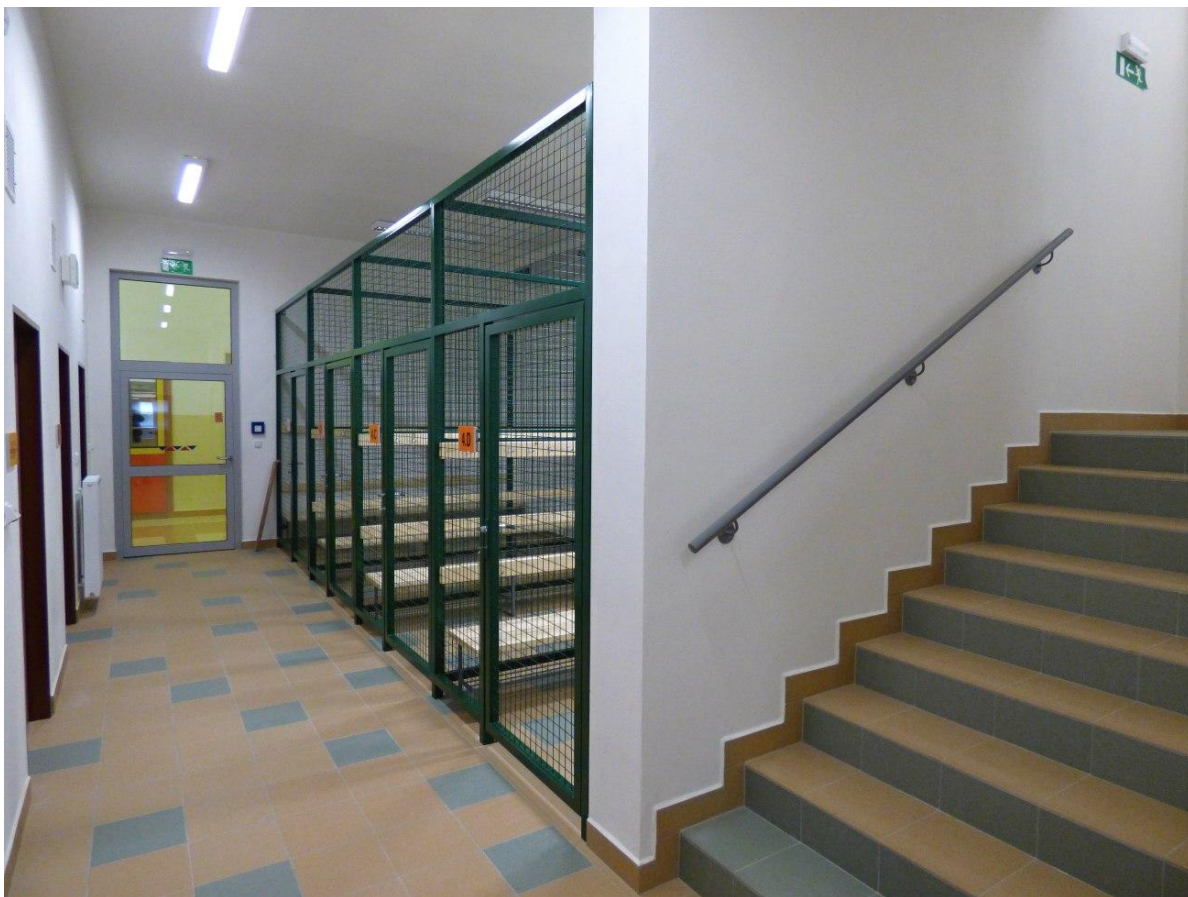
Přístavba v Rebcově ulici – šatnový blok
