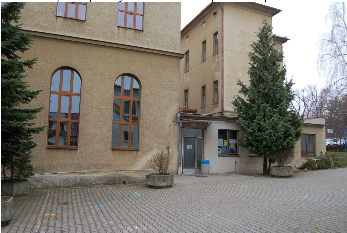
Původní objekt šaten postavený v roce 1977 (foto 24.6.2016)
