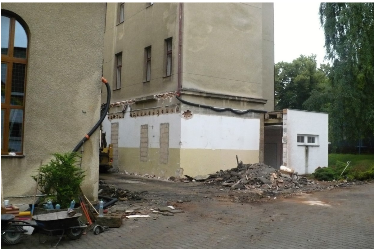
Zbouraná část šatnového bloku, místo nové přístavby (foto ze dne 30.6.2016)
